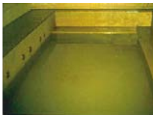
洗浄剤投入前
